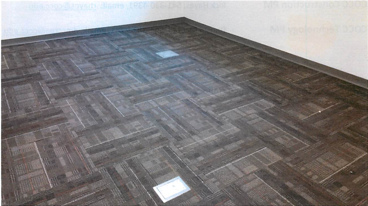
Data and AV Floorbox Installation – Computer Lab
